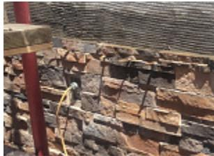
Bien qu'il s'agisse d'une exigence pour l'installation par temps chaud, cette méthode est également bénéfique dans les climats frais ou secs. Les fabricants de mortier modifié ou modifié par des polymères peuvent recommander d'éliminer cette étape. Veuillez contacter le fabricant du mortier modifié spécifié pour connaître ses recommandations sur les étapes d'hydratation de la pierre et de la première couche.
