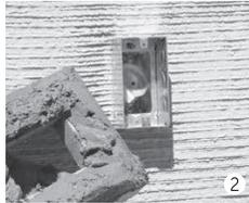
2 Appliquez le mortier au dos de la pierre de la boîte électrique ou du substrat préparé.
