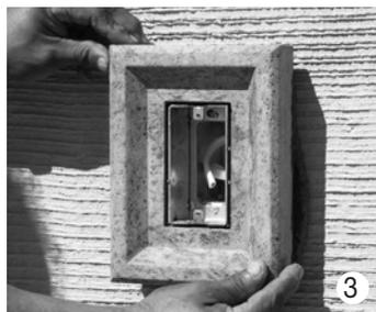
3 Centrez la pierre pour boîte électrique par-dessus la boîte d'extension. Nivelez et plombiez. Utilisez des cales escamotables si nécessaire.
